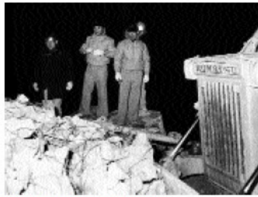
Năm 1984. Tại hiện trường cải tạo của dự án Seosan.
