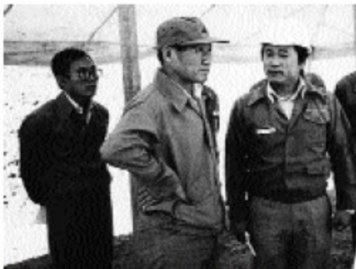
Thập niên 1970. Kiểm tra tiến độ tại công trường xây dựng thuộc dự án xây dựng nhà ở cho người dân ở thành phố Jeda, Ả-rập Sau-đi.
