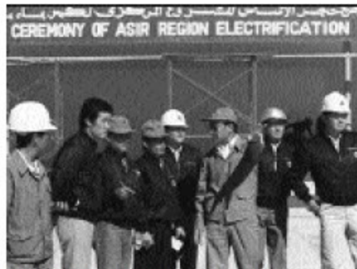
Thập niên 1970. Tại công trình xây dựng nhà máy điện quận ASIR.
