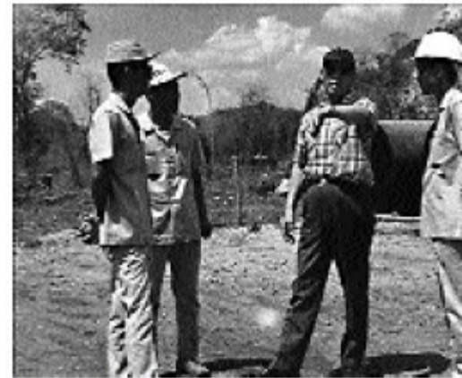
Năm 1966. Thảo luận tại công trường xây dựng đường cao tốc Pattani-Narathiwat, Thái Lan.
