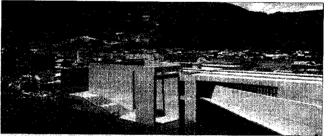
Toàn cảnh công trình.
