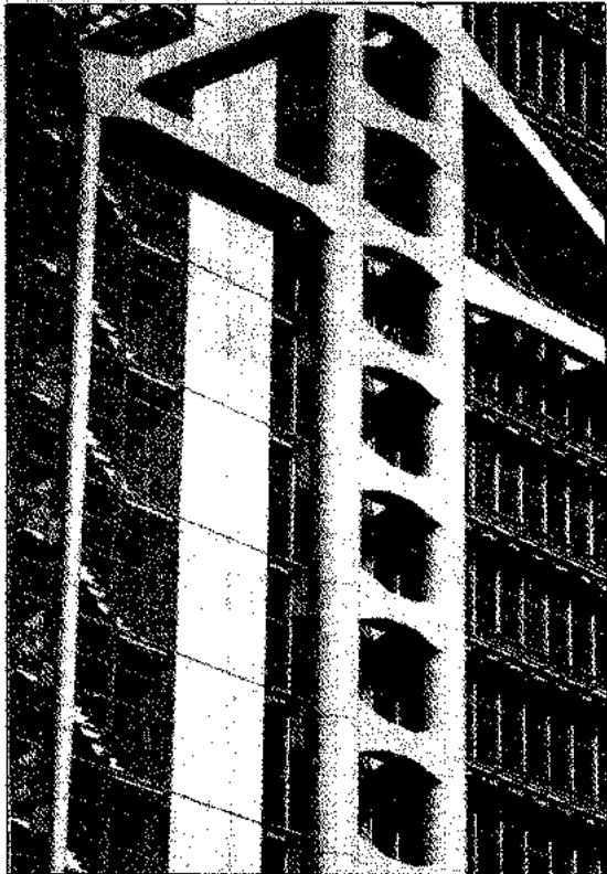
Một góc hình ảnh hệ thống kết cấu chính của công trình.
