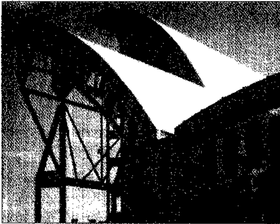
Góc mái công trình.
