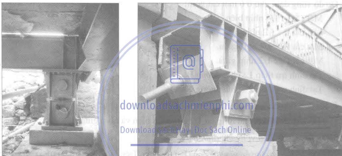
Hình 5.13: Cấu tạo gối cầu
