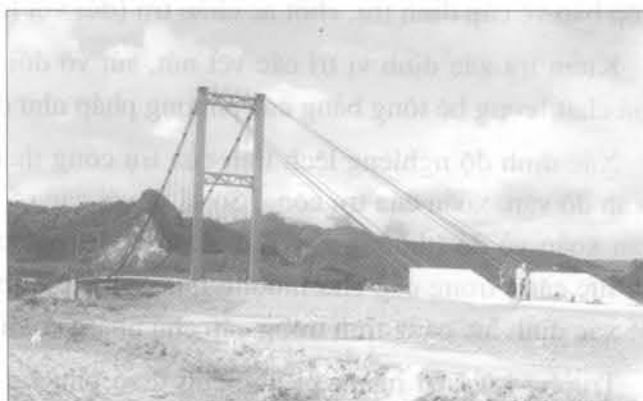
Hình 5.5: Chi tiết neo dây cáp chủ
