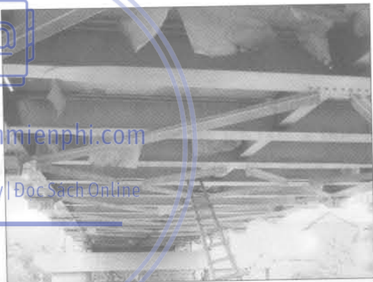
Hình 5.9: Hệ liên kết các dầm dọc
