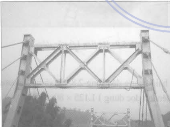
Hình 5.11: Hệ liên kết tháp cầu
