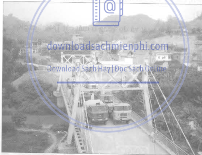
Hình 5.15: Sơ đồ xếp tải 1/2 nhịp chính
