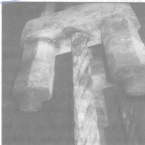
Hình 5.6: Ảnh chi tiết neo cáp
